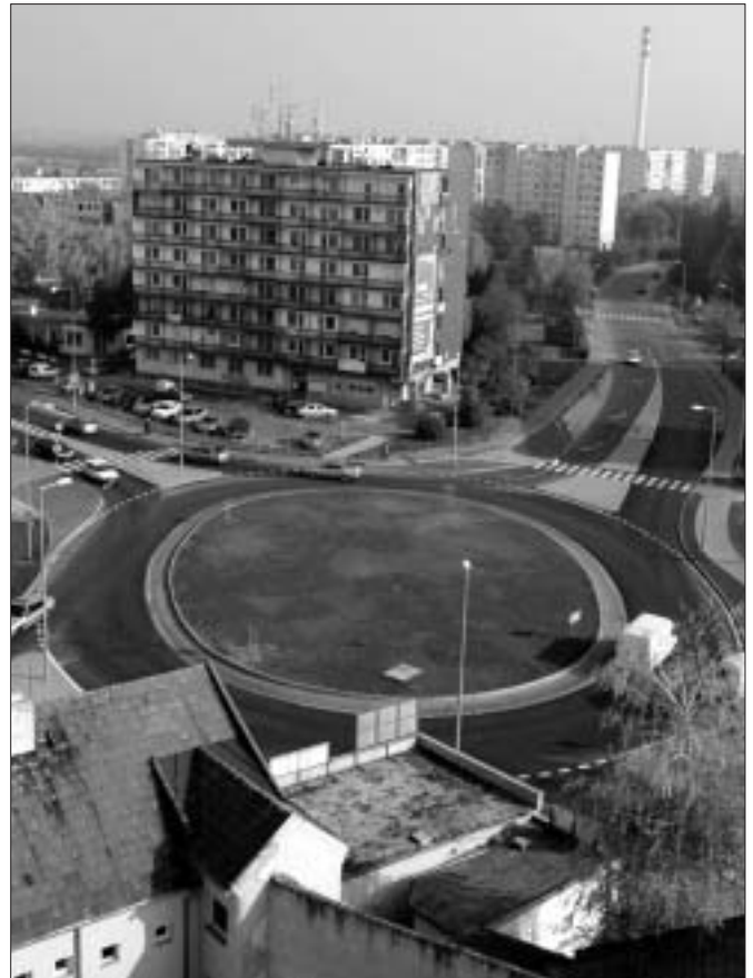
Križovatka na Hlavnej ulici po jej rekonštrukcii
