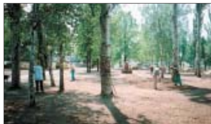
Az állomási park komplex felújítása a befejezéséhez közeledik / Komplexná rekonštrukcia mestského parku pri železničnej stanici je v záverečnej fáze.
