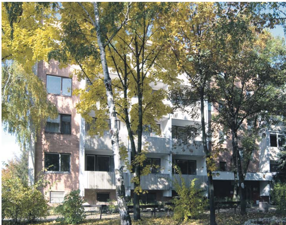
V zariadení pre seniorov na sídlisku Západ pribudne nadstavba.
